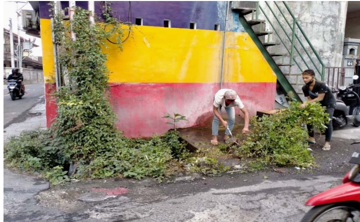
Gambar 2 Pembersihan rumput di tiang listrik
